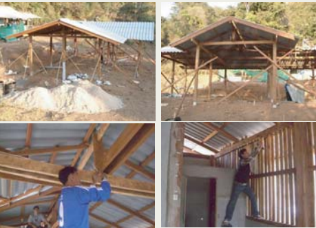
ทีมงานบำรุง ติไซน์ และผู้บริหารกำลังเดินสายไฟ ช่วยงานก่อสร้างโรงเรียน
